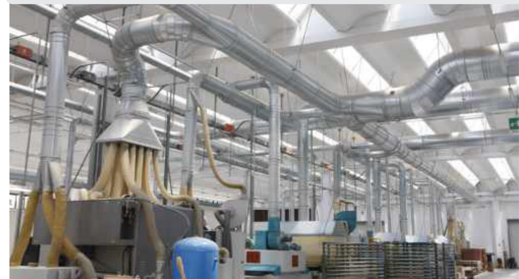
Ολοκληρωμένο δίκτυο αεραγωγών απορρόφησης / Completed aspiration line
